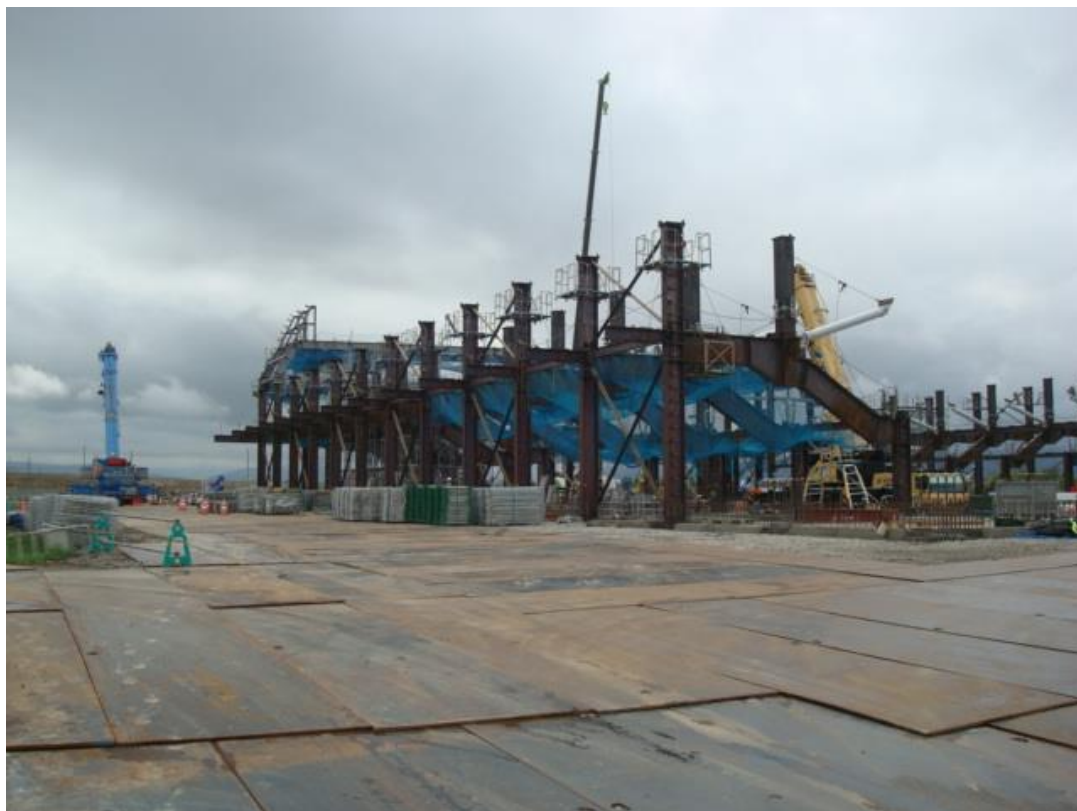
柱が立ちました。県立武道館の正面玄関辺りになります。
