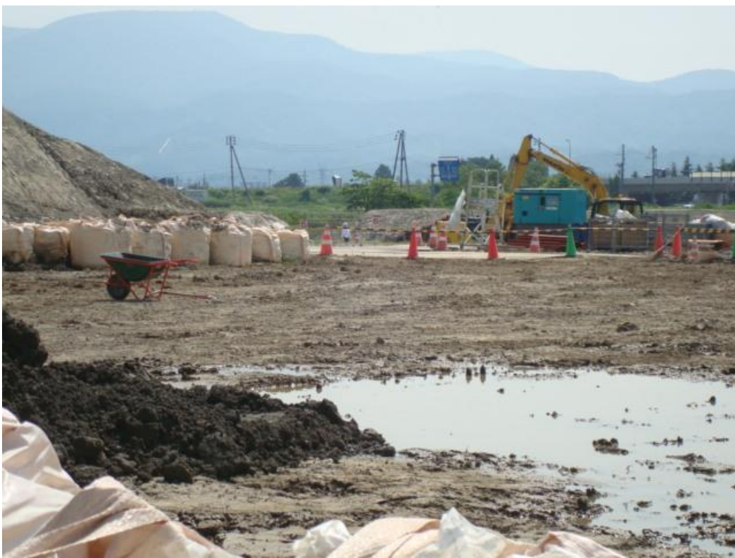
上の写真はひと冬野晒しにした土を軟弱地盤と交換します。 下の写真は、弓道場辺りに相当するところの掘削工事です。
